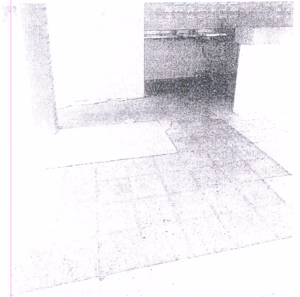
Foto 36- Desplacamento do piso de grande parte do refeitório.
